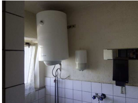
Obr. č. 6: Zásobníkový ohrievač TÚV
