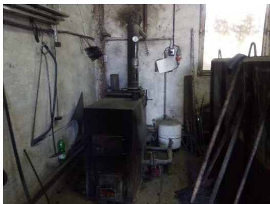
Obr. č. 7: Kotel na pevné palivo
