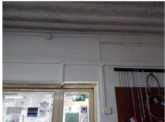
Obr. č. 16: Dodatočne montované rozvody EE
