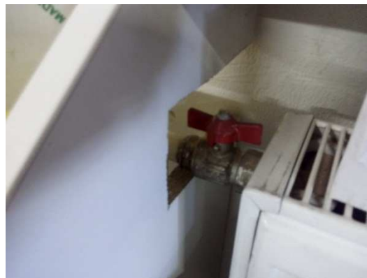
Obr. č. 8: Ventil vykurovacieho telesa
