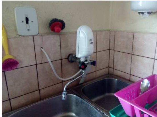
Obr. č. 5: Prietokový ohrievač TÚV
